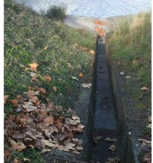
Le cours des Alpes dispose d'un réseau d'assainissement pluvial surfacique et enterré permettant de collecter les écoulements provenant du massif à l'Est. Son profil descendant Sud/Nord et la présence d'une bande continue de maisons entre cet axe et la parcelle à aménager, en plus du réseau, permettent de considérer l'absence d'apport extérieur par l'Est.
